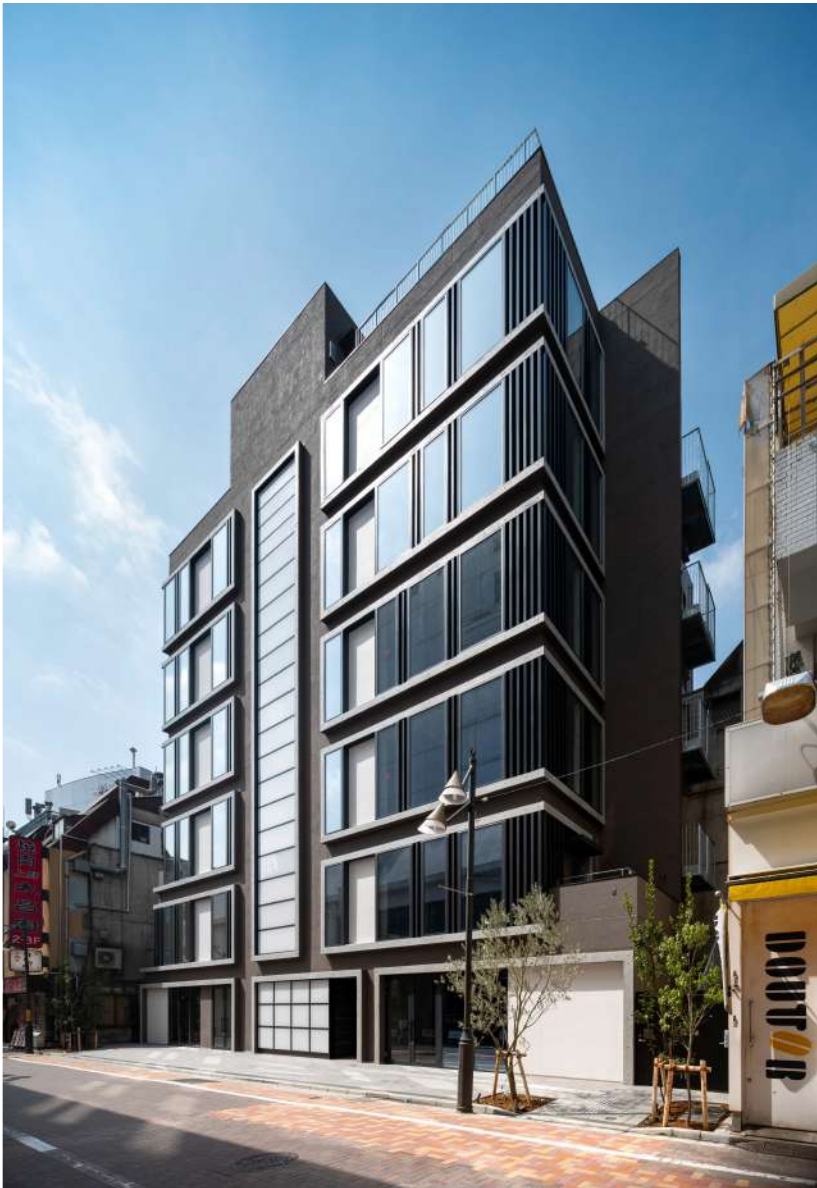
各階の店舗を打ち放しのボーダーで区画したファサード全景
