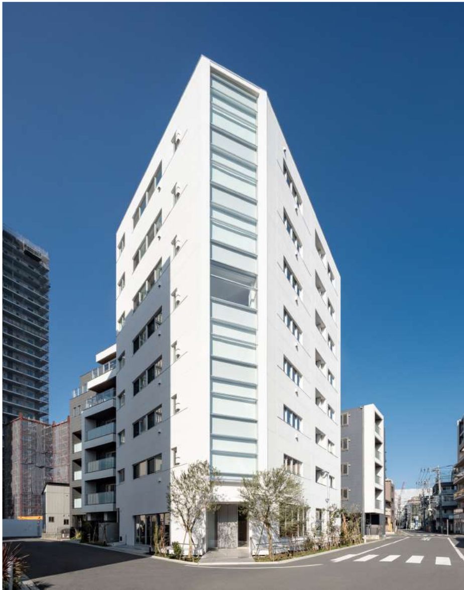
コーナーをカーテンウォールとした外観全景
