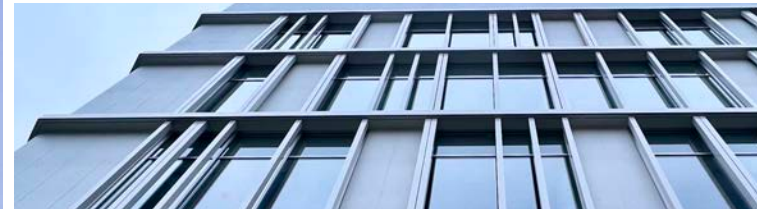
ファサード見上げ
