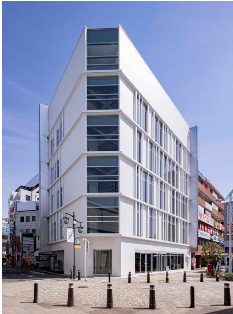
コーナーをエントランスとカーテンウォールとした外観全景
