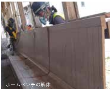
ホームベンチの解体
