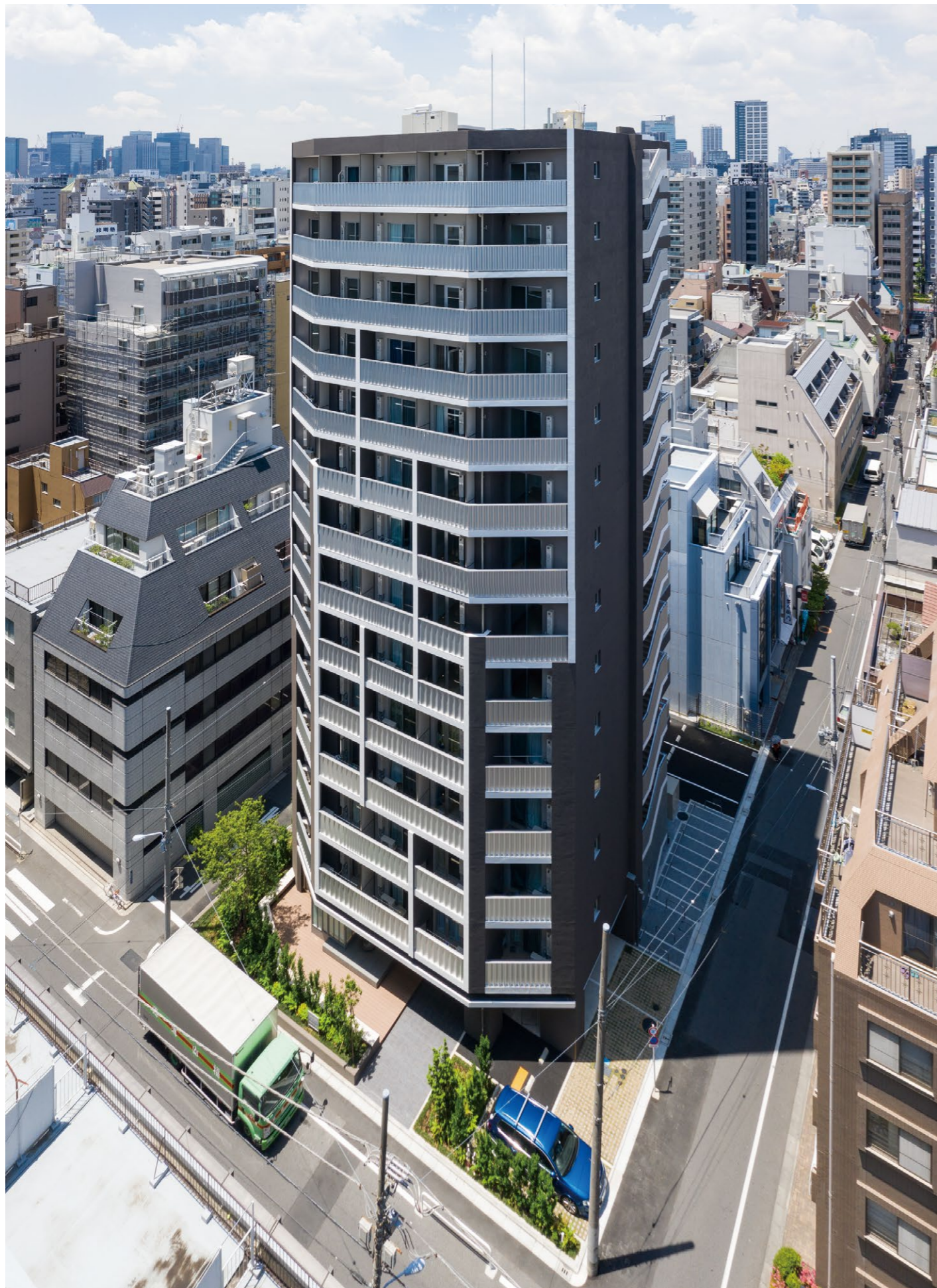
根据天空率设计的底层退进部分，作为街道的半共用空间进行了整備
