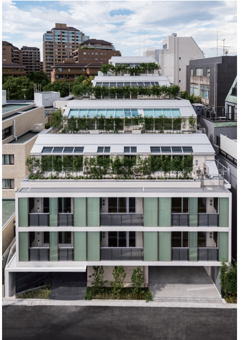
トップライトと一体化したサッシュでテラスと一体化した北側セットバック部
