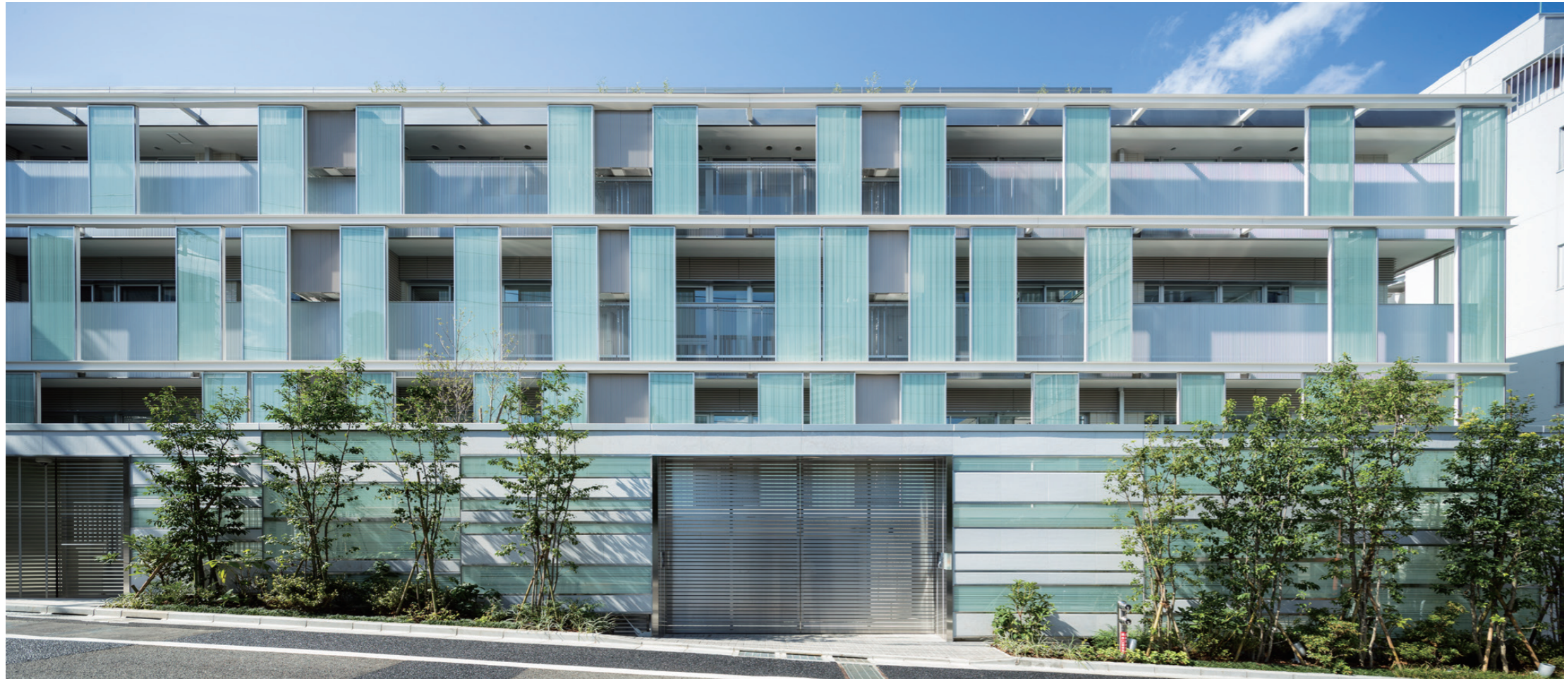
プリントガラススクリーン、石、金属、格子手摺等の素材のレイヤーを重ねることで、閉じながら開く重層的なファサードを構成
