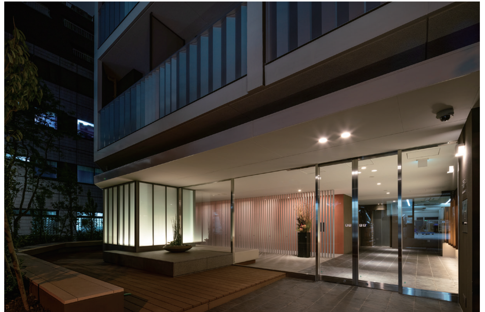
行灯柱を中心に、デッキテラスとエントランスホールが連続する1階共用部
