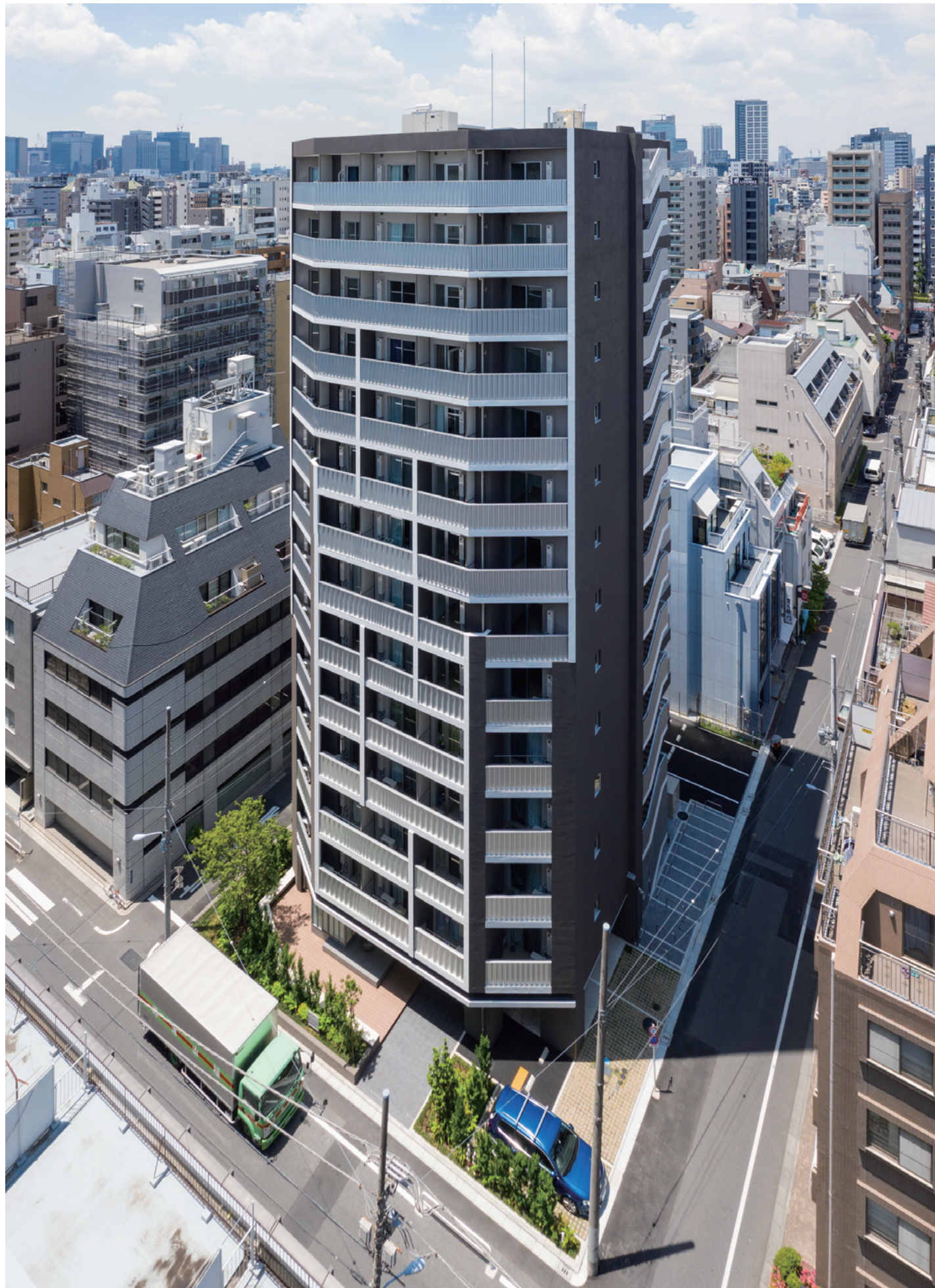
天空率によりセットバックした足元部分を、街の半共用空間として整備している
