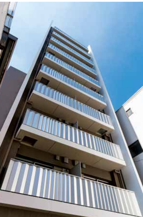
時々刻々表情を変えるアルミ折半によるバルコニー手摺り 左／北側ファサード見上げ 右／南側ファサード見上げ
