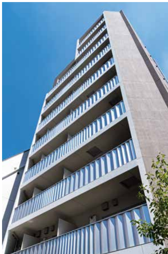
時々刻々表情を変えるアルミ折半によるバルコニー手摺り 左／北側ファサード見上げ 右／南側ファサード見上げ
